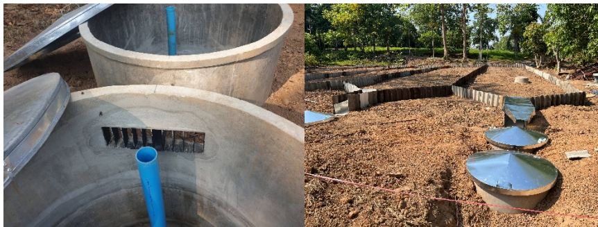
ภาพ บ่อเก็บน้ำและตะแกรงทอนปริมาณน้ำฝน
