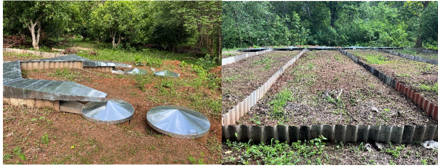
ภาพ การเชื่อมขอบบ่อและท่อเก็บน้ำ พร้อมแผ่นสังกะสี
